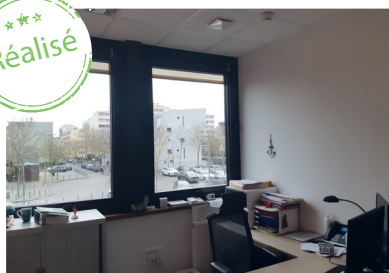
Exemple des travaux de rénovation réalisés dans les bureaux annexes de l'Agglomération Montargoise à la Chaussée : remplacement des menuiseries, isolation du plafond et raccordement au chauffage urbain. Amélioration de la performance énergétique : de D à B.
