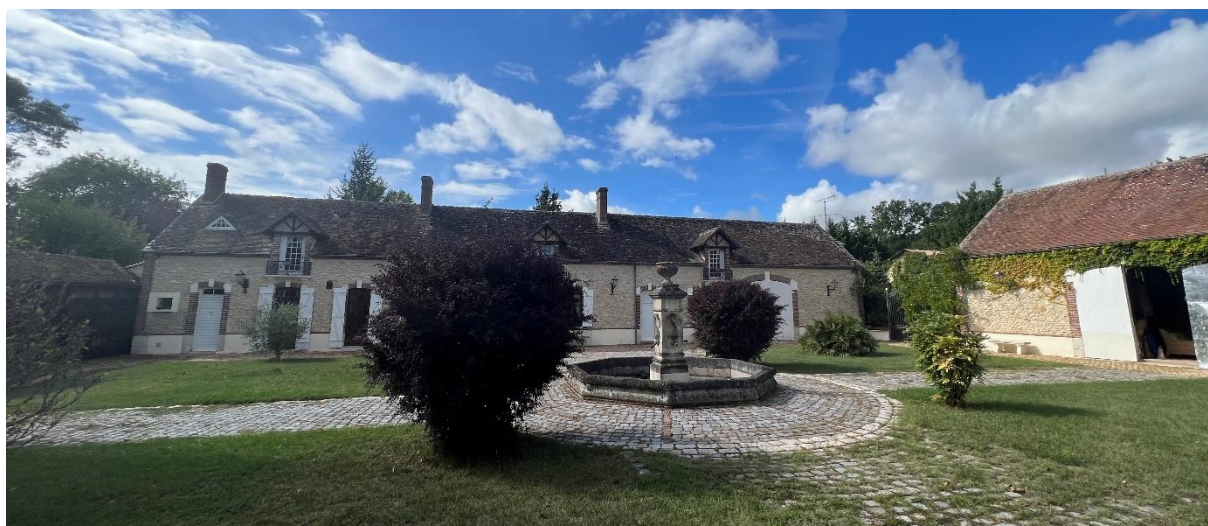
Figure 9 - Vue sur le bâtiment principal
