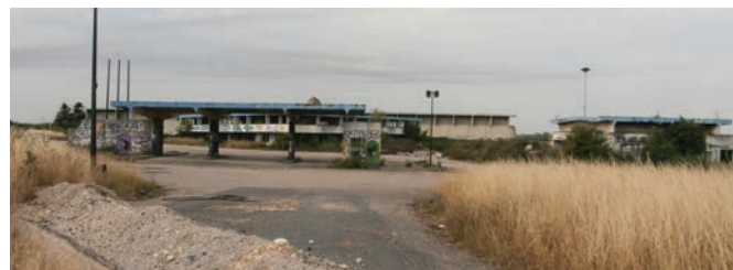
Bâtiment d'activité en friche, Commune de Mormant-sur-Vernisson
