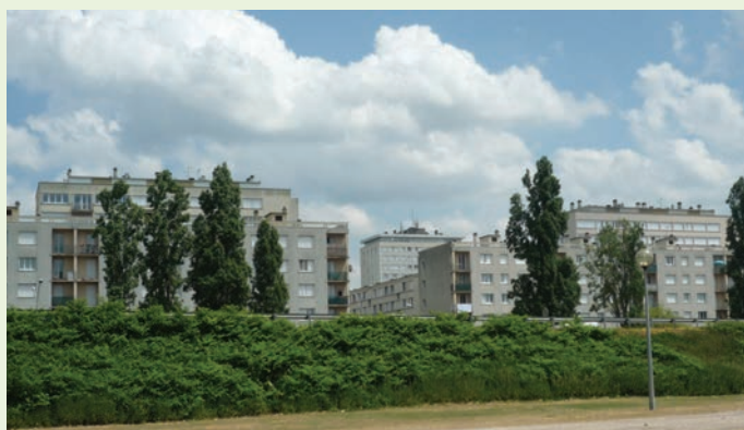
Logement social, commune de Montargis
