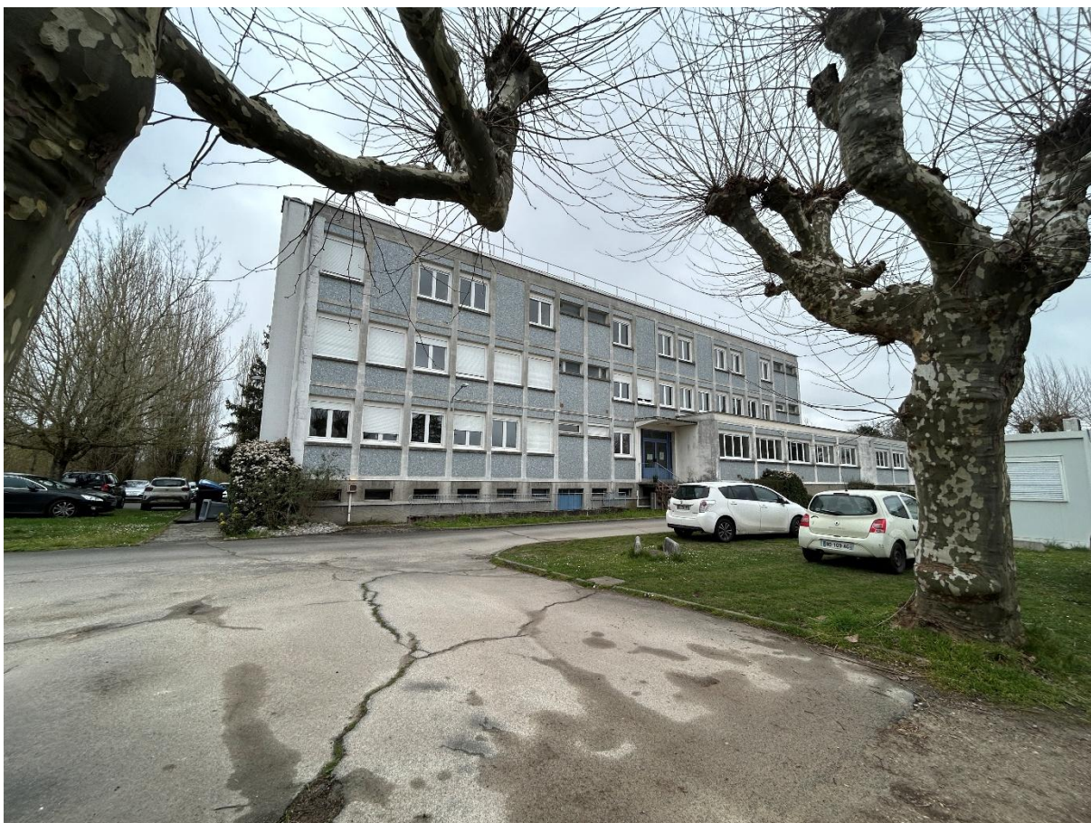
Figure 9 - Actuel bâtiment de l'IFPS à Châlette-sur-Loing
