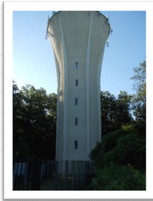
Vue générale du réservoir sur tour
