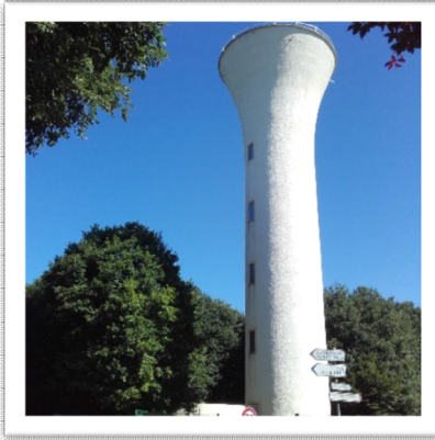
Vue générale du réservoir sur tour
