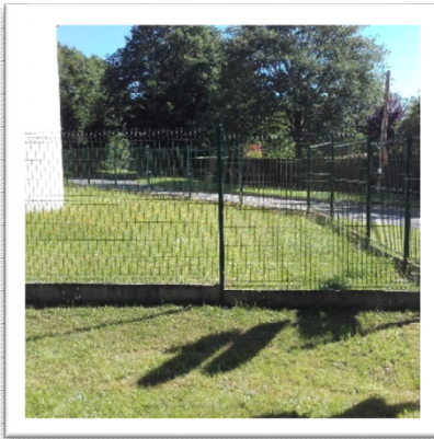
Grillage en bon état sur l'ensemble de la parcelle
