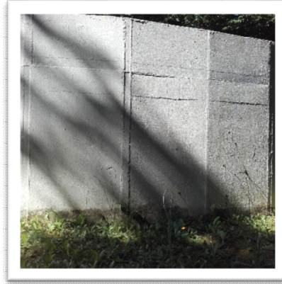
Vue de la bâche semi enterrée
