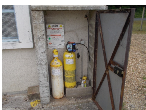
Local dépôt de chlore
