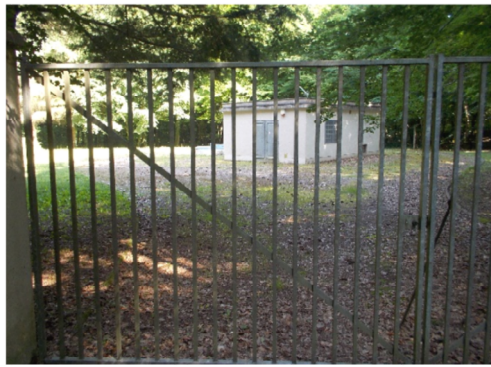
Vue générale station de production
