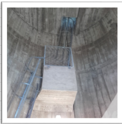
Vue intérieure très bon état du béton
