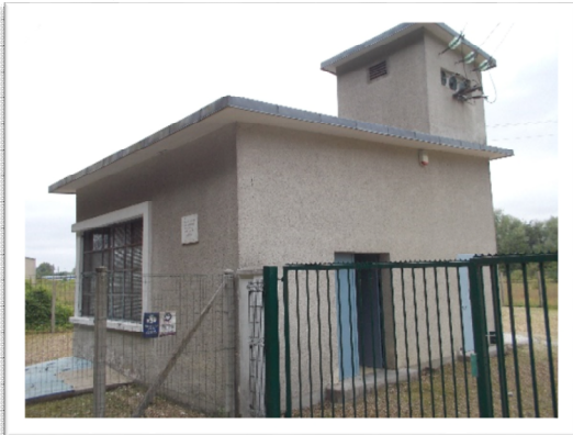
Vue générale station de production P2
