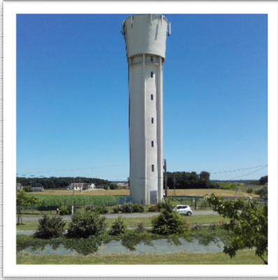
Vue générale du réservoir sur tour
