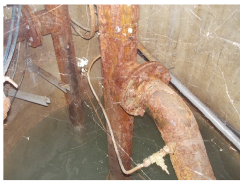
Forage et colonnes de pompe
