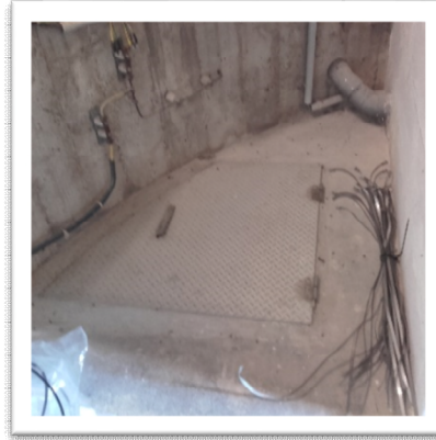
Accès bâche enterrée sous réservoir
