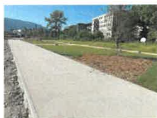
Exemple d'un enrobé clair à liant végétal
