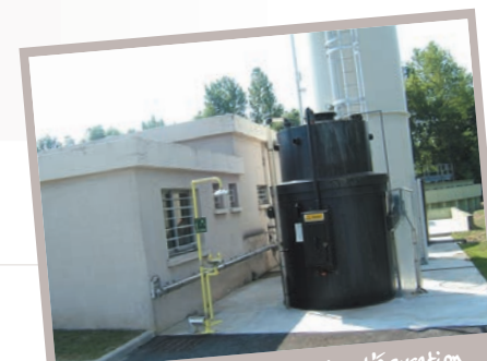
Réhabilitation de la station d'épuration à Amilly
