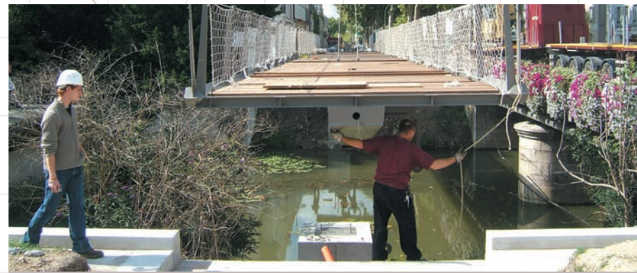
Pose des passerelles au Pont Sédillot à Montargis
