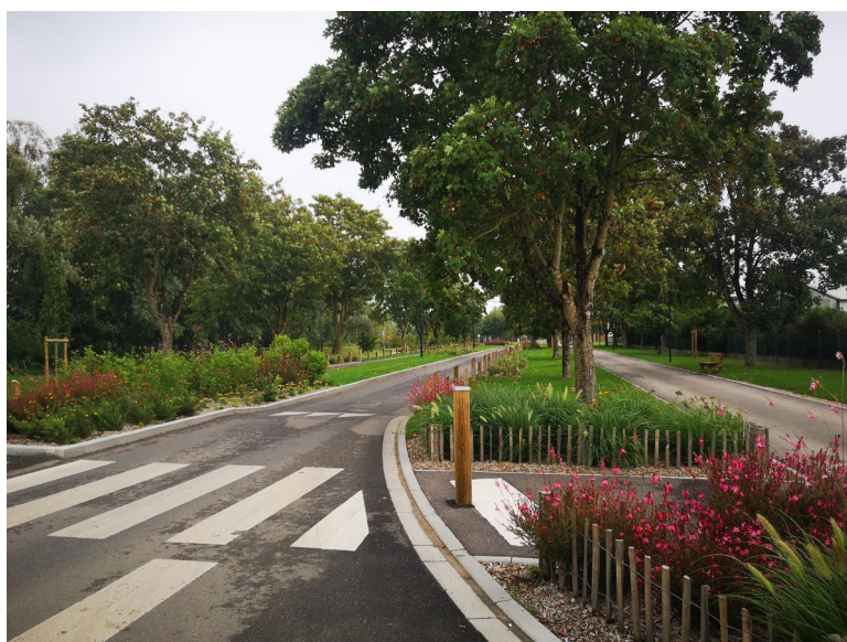
Travaux de la rue du Gué aux Biches à Chalette-sur-Loing
